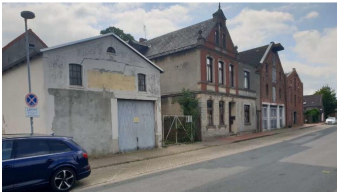
Abbildung 6: Fotos Bestandsgebäude Hafenstrasse Nr. 4 bis 6
